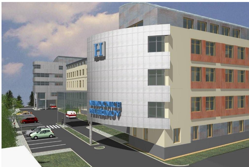
Rekonstrukce hlavní lůžkové budovy nemocnice v Pelhřimově
