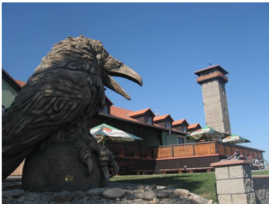
Přístavba ubytovací kapacity penzionu Rumburak, Bítov
