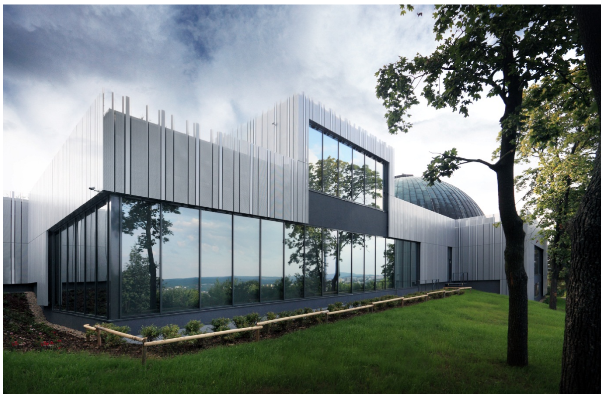
Obrázek č. 7: Budova Hvězdárny a planetária Brno
