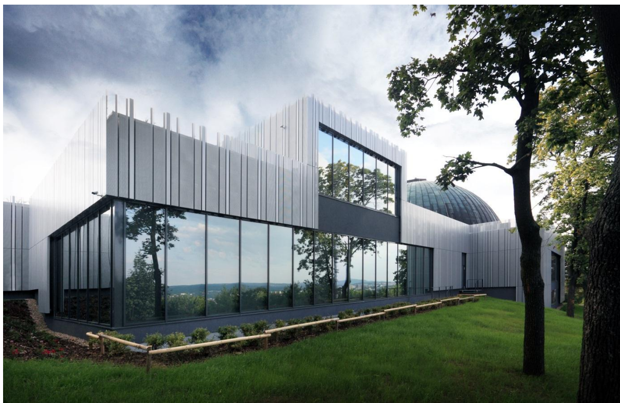
Obrázek č. 7: Budova Hvězdárny a planetária Brno
