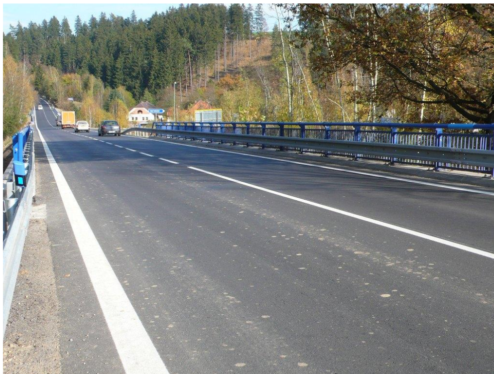
Zrekonstruovaný most přes železniční trať na silnici II/602 při výjezdu z Jihlavy směr Brno.
